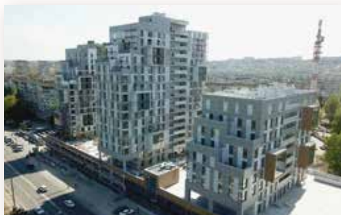
«Строитель П», ЖК «5 КОНТИНЕНТ» РП-10кВ выполнено на компактных ячейках Xiria
