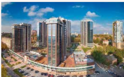
«Строитель П», ЖК «PANORAMA» г. Днепр, ул. Симферопольская, 2к
