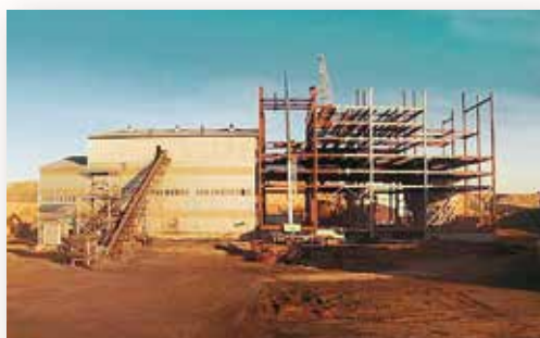
Велта, ГОК Сборка и поставка щитового оборудо- вания
